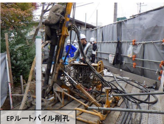
親杭工削孔 ダウンザホール
